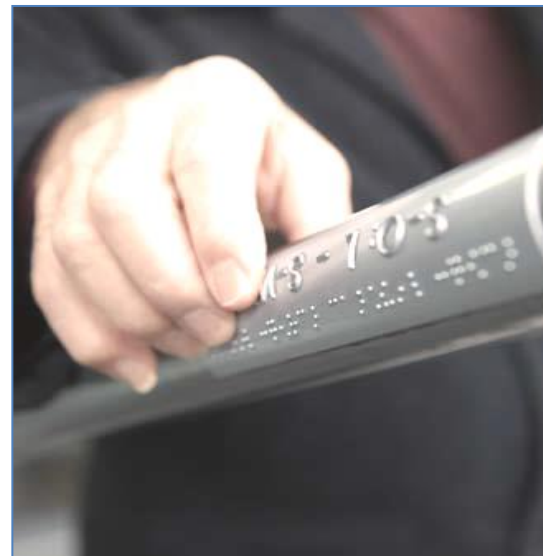
Kontrastreiche Gestaltung der Handläufe in einem Schul-Altbau. Treppenantritt und Stufenmarkierung sind demgegenüber noch nicht perfekt.
