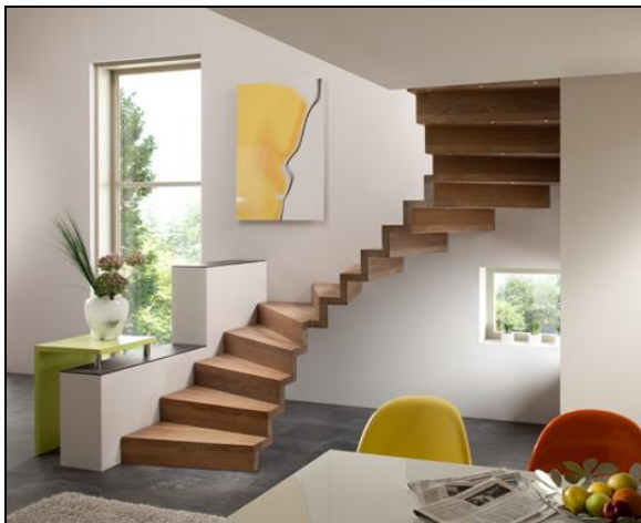
Abb. 1 Treppe hochelegant, aber ohne (Geländer und) Handlauf unverantwortlich
