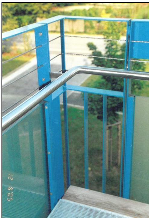
Abb. 7 / 8 Vorbildliche Handlaufführung im Außen- und Innenbereich
