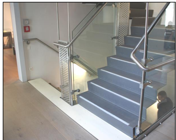
Abb. 2 Weitgehend beispielhafte Handlaufgestaltung
